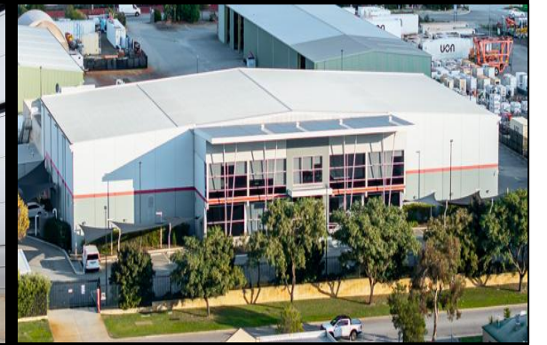
MALAGA DC, PERTH, WA
