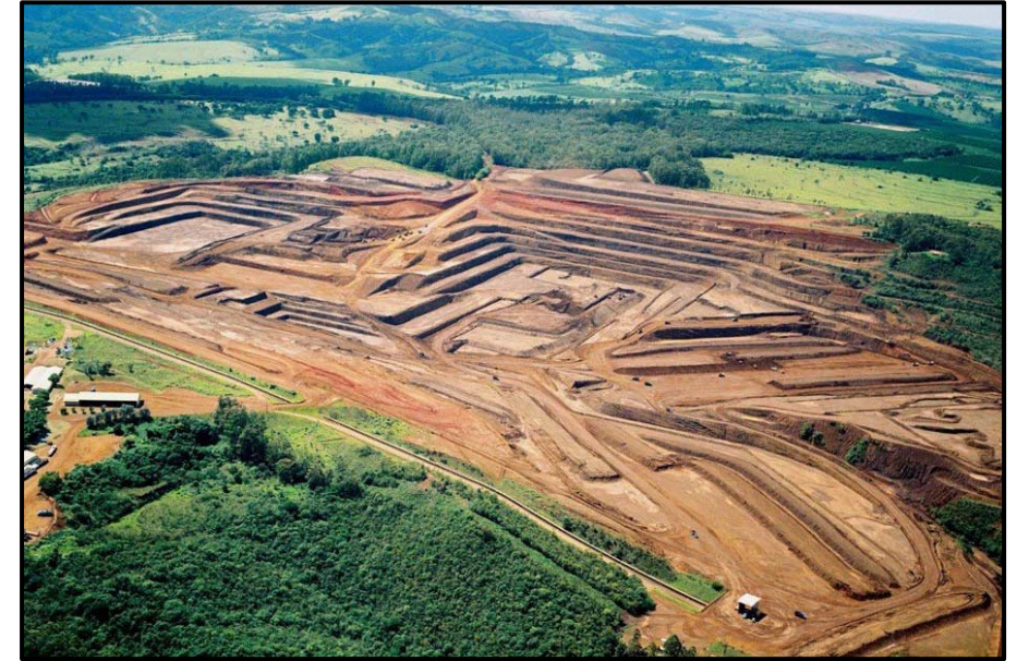
ARAXÁ OPEN PIT
