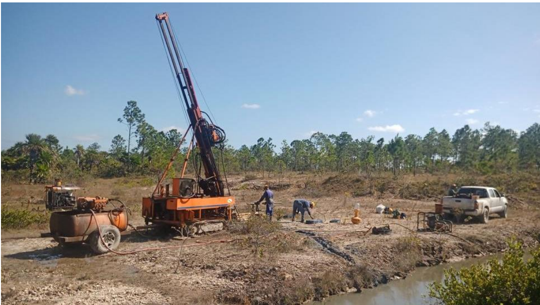
Drilling - El Pilar
