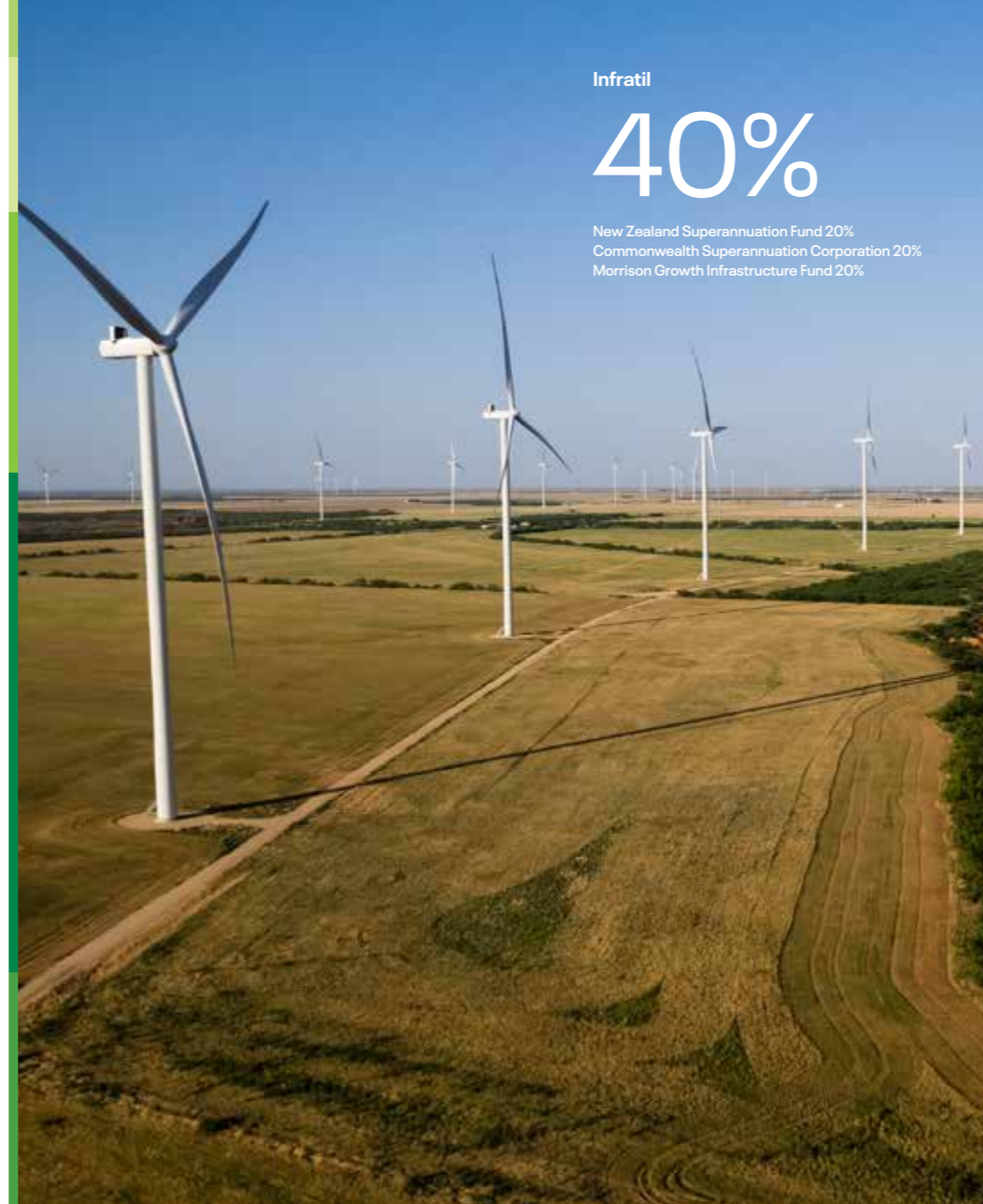
The 243MW El Campo wind farm, Texas
