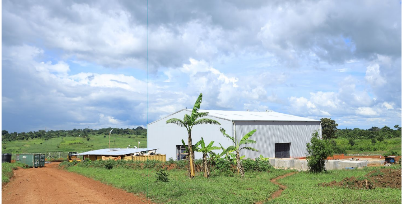
Figure 4: Makuutu Stage 1 Demonstration Plant.
