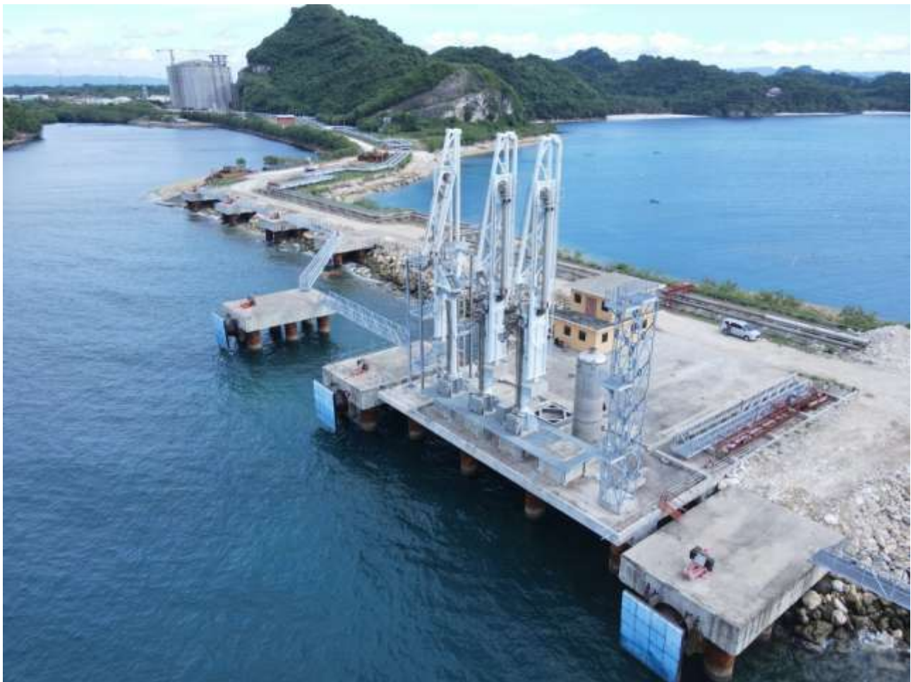
LNG Storage Hub
