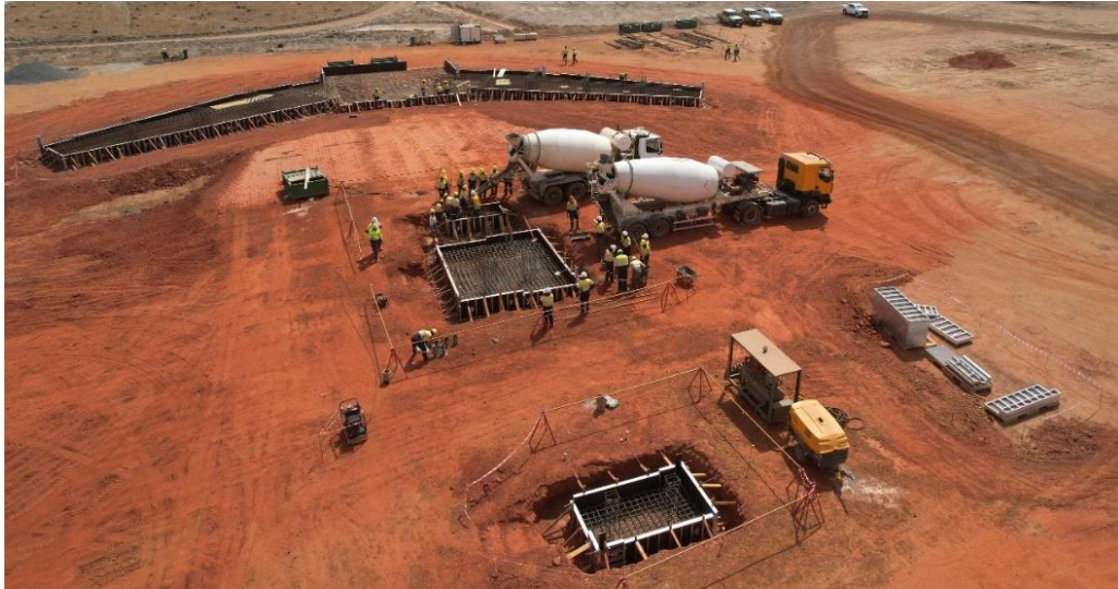
First concrete pour at Goulamina
