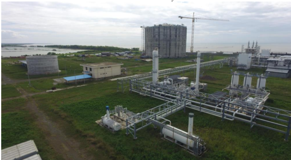
Sengkang LNG Plant
