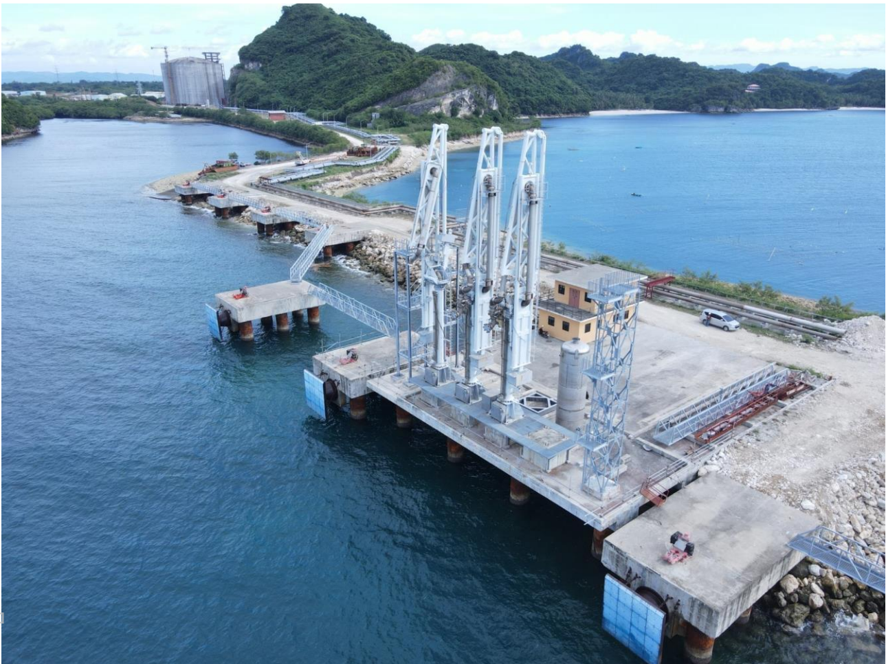
LNG Storage Hub
