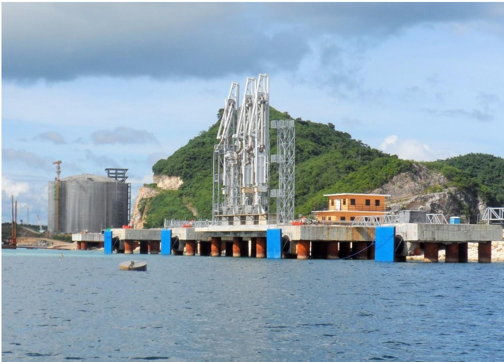
LNG Storage Hub
